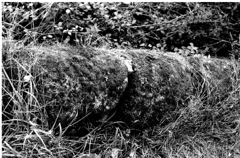
Fig. 3 - Éléments de demi-cylindres servant de couverture au-dessus du mur de l'ancien cimetière.
