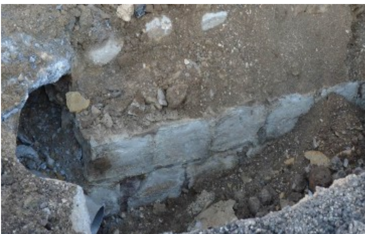
Aqueduc à l'angle de la maison de M et Mme Jean Mas
